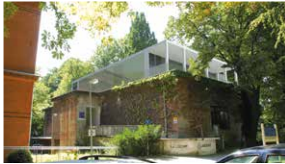
Das Baumhaus entsteht auf dem Bunkerdach neben dem historischen Verwaltungsgebäude
